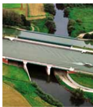
Flutbrücke über die Leine
